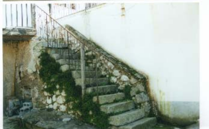
Poggioli tradizionali (in legno con parapetto alla trentina e in pietra con parapetto in ferro battuto) e scala in pietra con parapetto in ferro battuto
