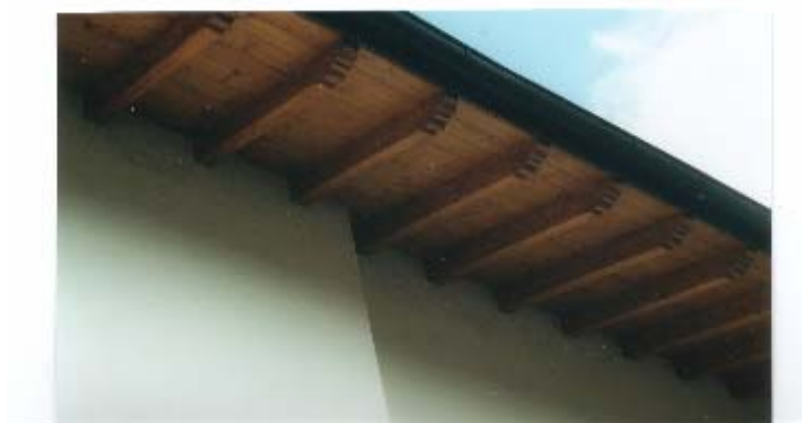
Sottogronda con travetti in vista
